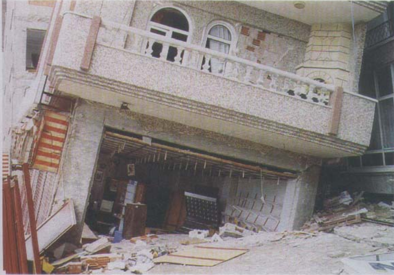
17 Ağustos 1999 İzmit Körfezi depreminde sivilaşma sonucu zemine gömülmüş bir yapı.
