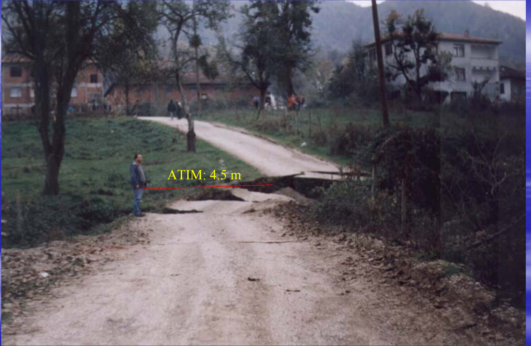
Dağdibi Köyü'nde (Düzce Güneyi) 12 Kasım 1999 Düzce Depremi Kırığı
