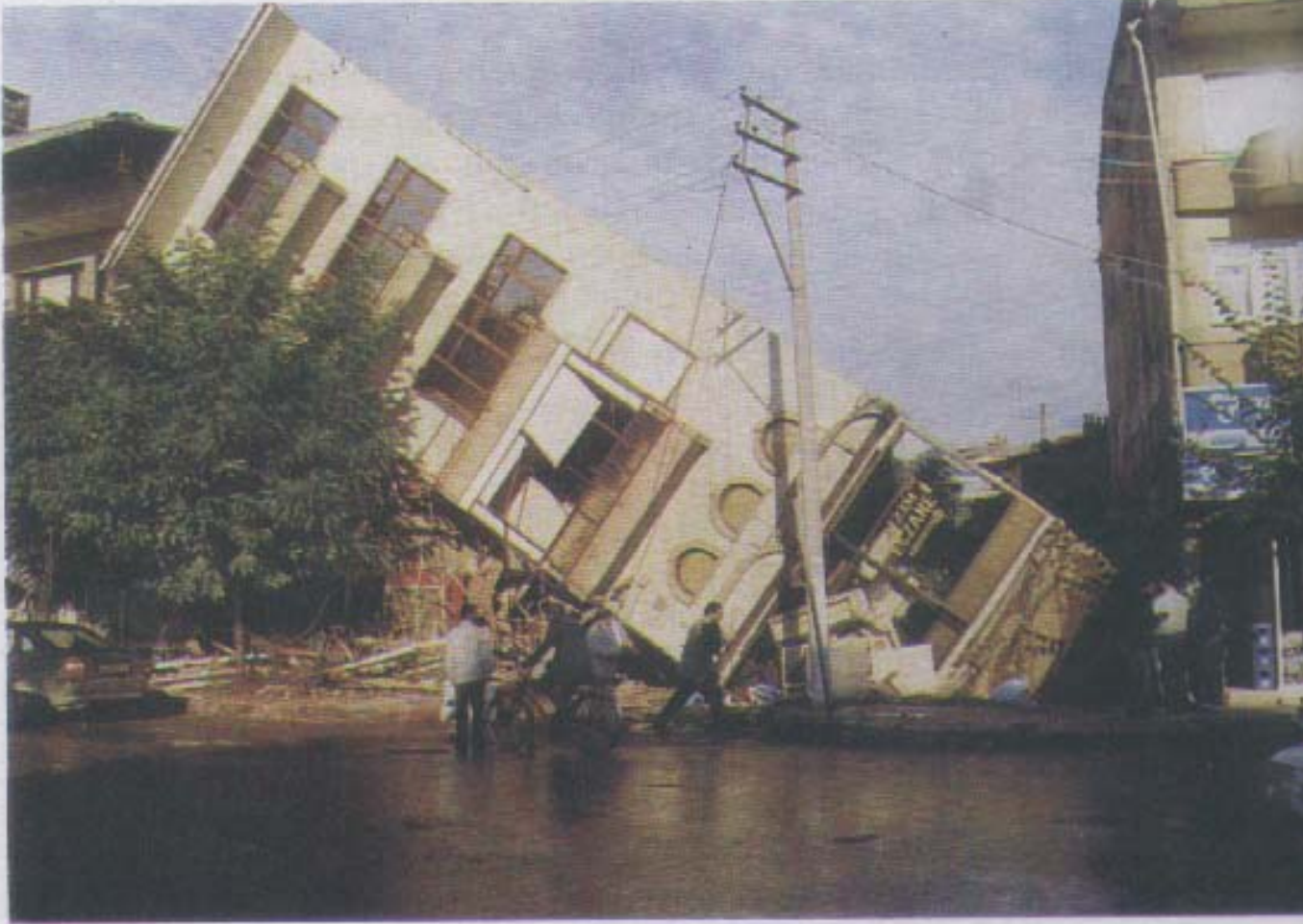
17 Ağustos 1999 İzmit Körfezi depreminde sivilaşma sonucu devrilmiş bir bina.
